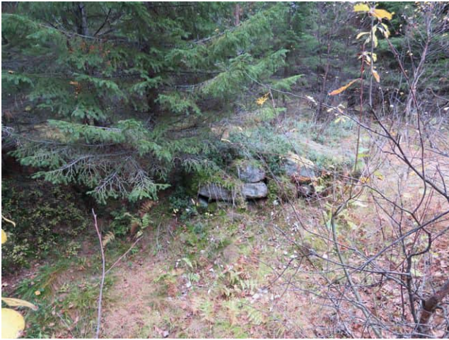
Alakohde 76-2, rakennuksen perustus,
