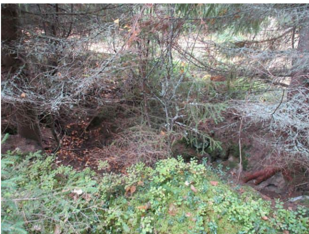
Alakohde 75-2, rakennuksen perustus, heinän peittämä
