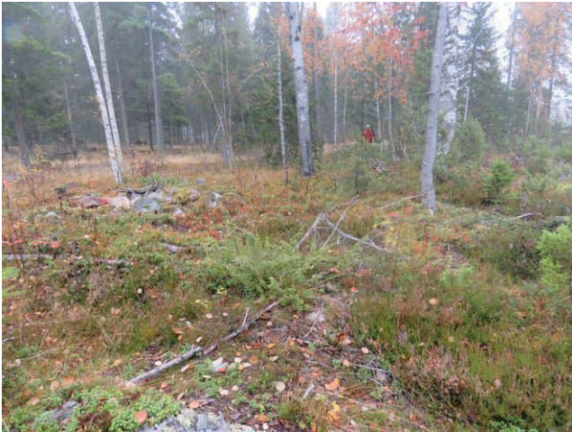
Alakohde 73-2, rakennuksen perustus
